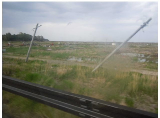
(津波により倒れた電柱)
