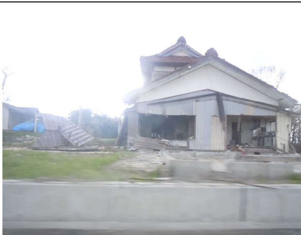
(倒壊した家屋)
