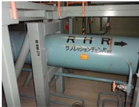
< Bの対策例 > 配管等の不燃性材料の使用
