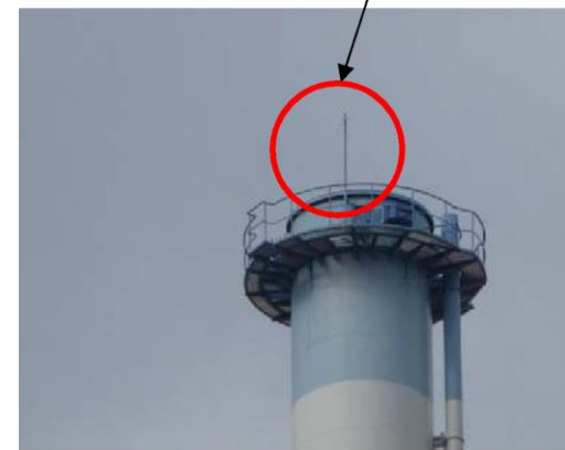
< Cの対策例 > 排気筒の避雷針設置
