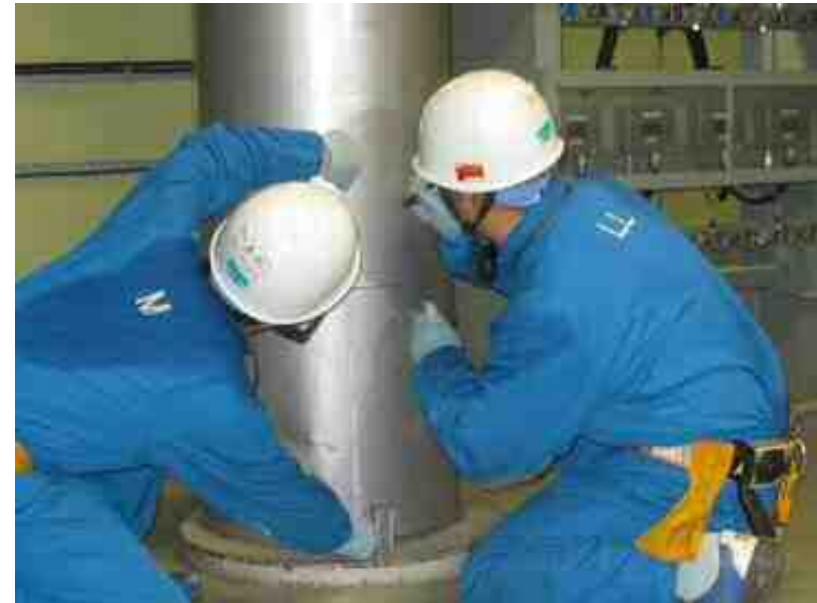
配管へのマーキング作業
