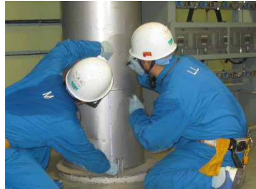
配管へのマーキング作業
