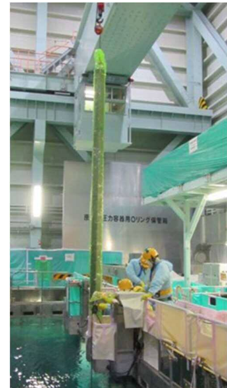
新燃料除染作業
