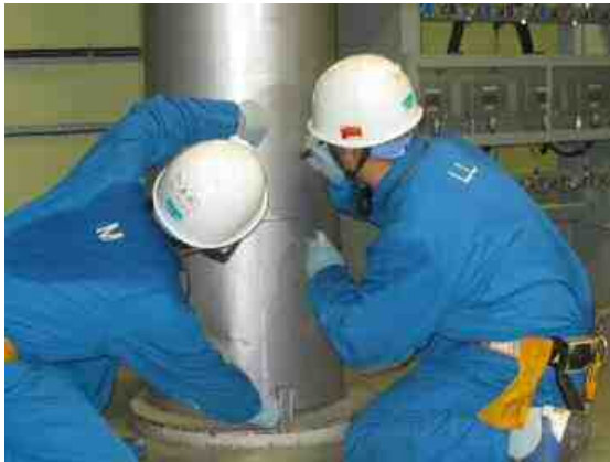
汚染状況の調査 (線量率測定箇所のマーキング)
