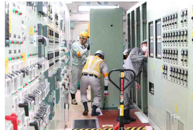
管理区域外にある役目を終えた設備の解体撤去 (中央制御室制御盤の撤去)
