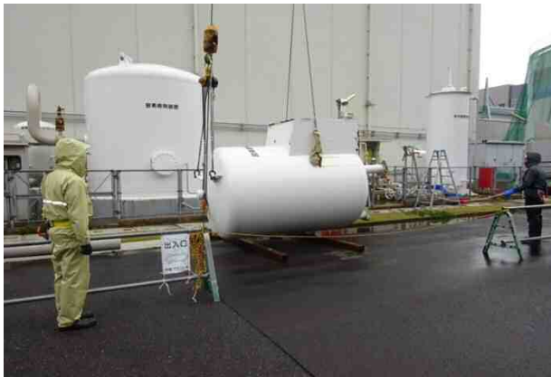
管理区域外にある役目を終えた設備の解体撤去 (タンクの吊り上げ)
