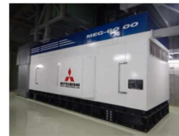
ガスタービン発電機
