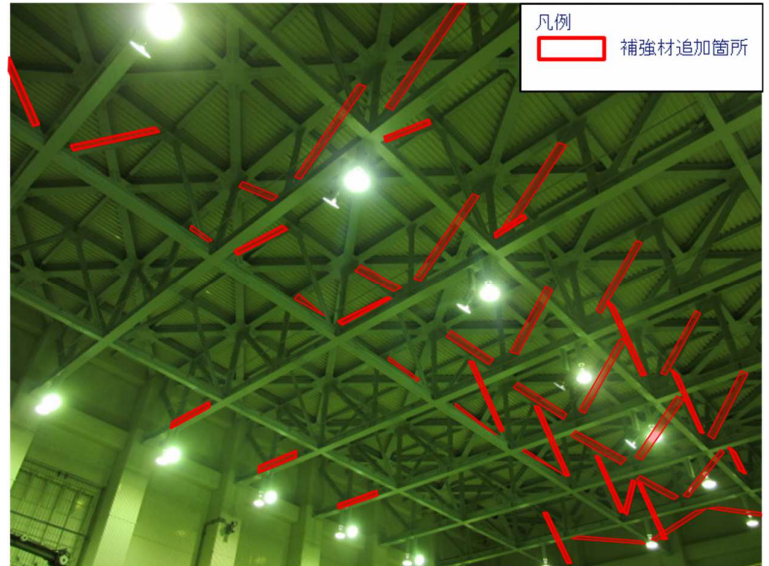
原子炉建物耐震補強工事状況
