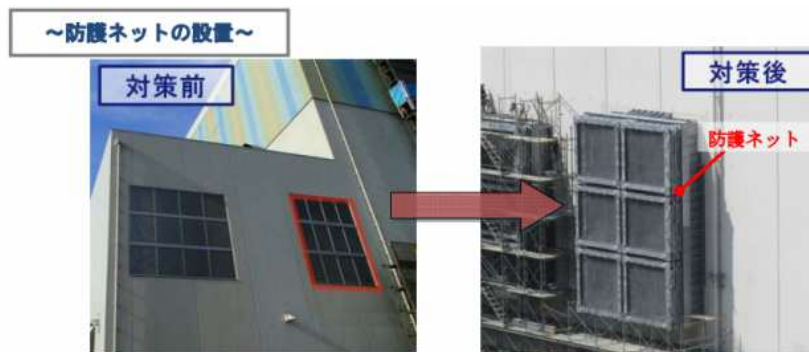
図28 飛来物への対策（竜巻防護ネット）
