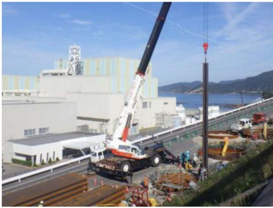
H鋼の建て込み
