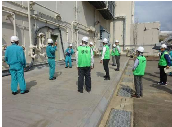
(低圧注水接続口)
