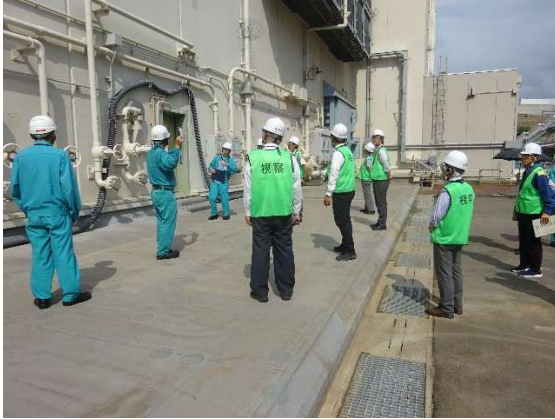
現地視察：低压代替注水の接続口
