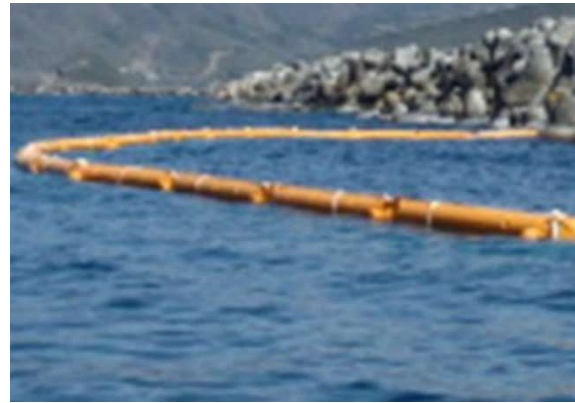
図 4 7 シルトフェンスの概念図
