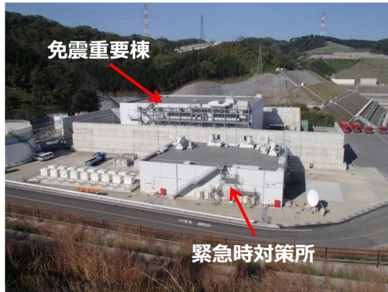
図 4.4 緊急時対策所と免震重要棟
