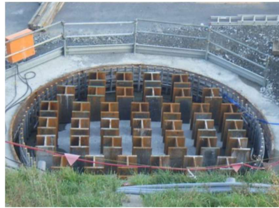
コンクリート打設
