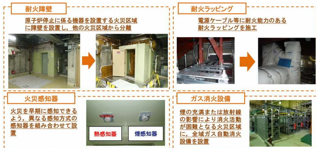
図31 火災防護対策の例
