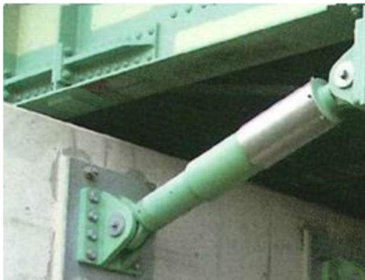
図9 単軸粘性ダンパ（橋梁への設置例）
