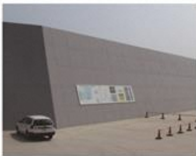
海側全域を囲んだ防波壁
