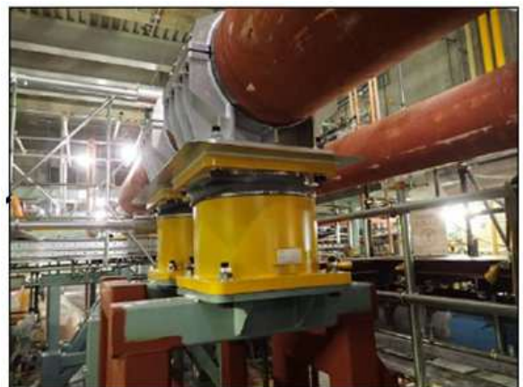
図 三軸粘性ダンパの設置例
