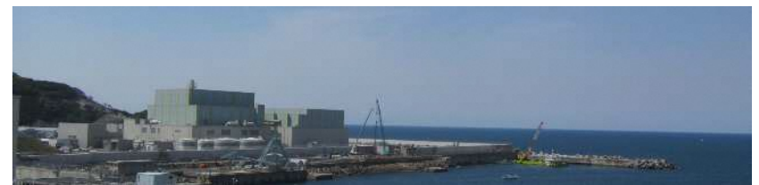
敷地東側からの全景
