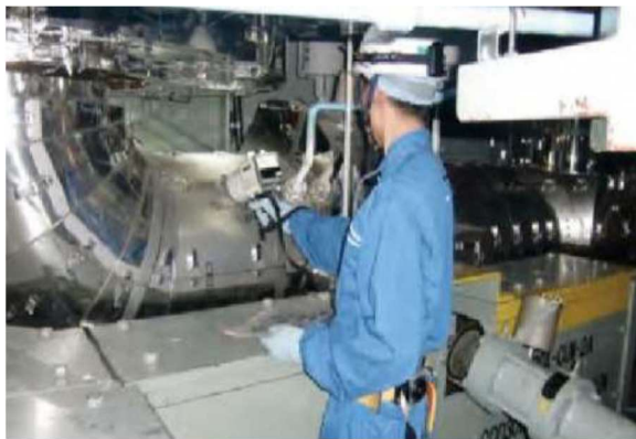
図2 配管の外部からの線量率測定
