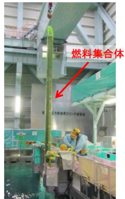
図1 新燃料の引き上げ
