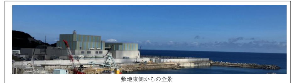
敷地東側からの全景
