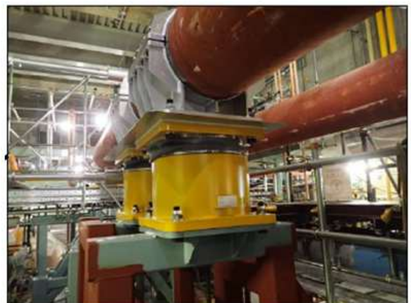
図 三軸粘性ダンパの設置例
