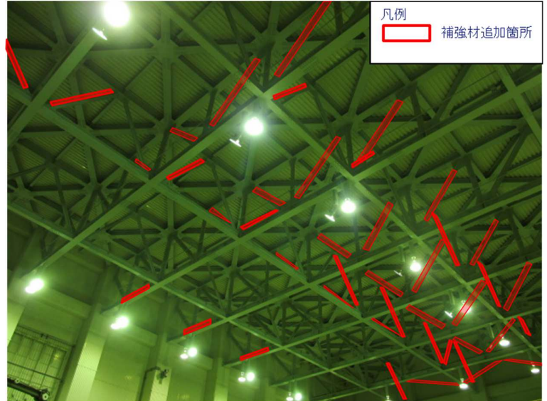
原子炉建物耐震補強工事状況
