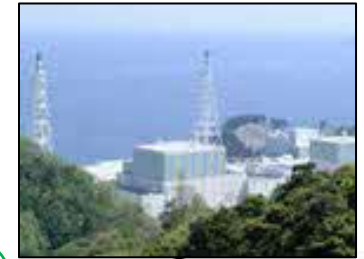
島根原子力発電所
