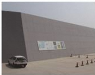
海側全域を囲んだ防波壁
