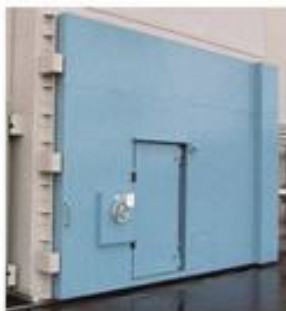
建物外側の水密扉
