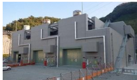
ガスタービン発電機建物 外観
