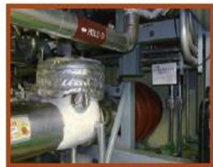
耐震補強工事前
