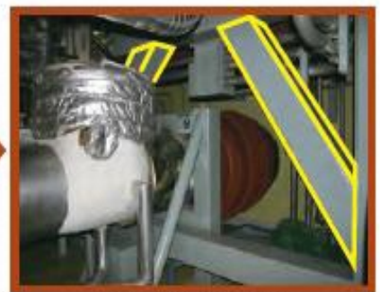
耐震補強工事後
