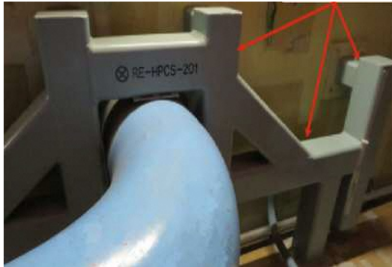
<支持構造物(約1万箇所)>
