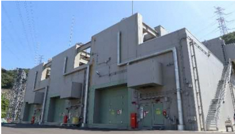
＜ガスタービン発電機(2台)＞
