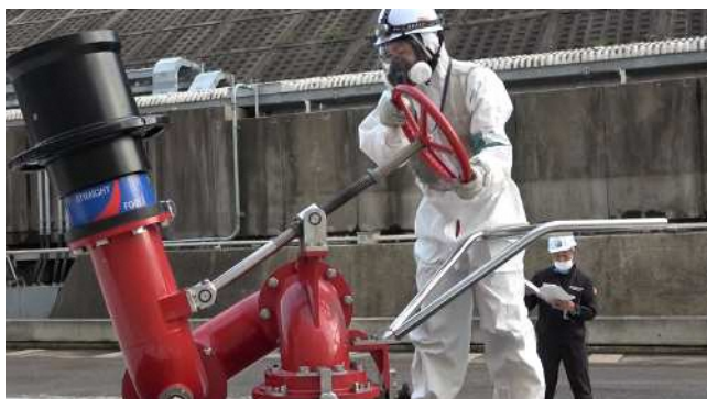
放水砲による放水準備
