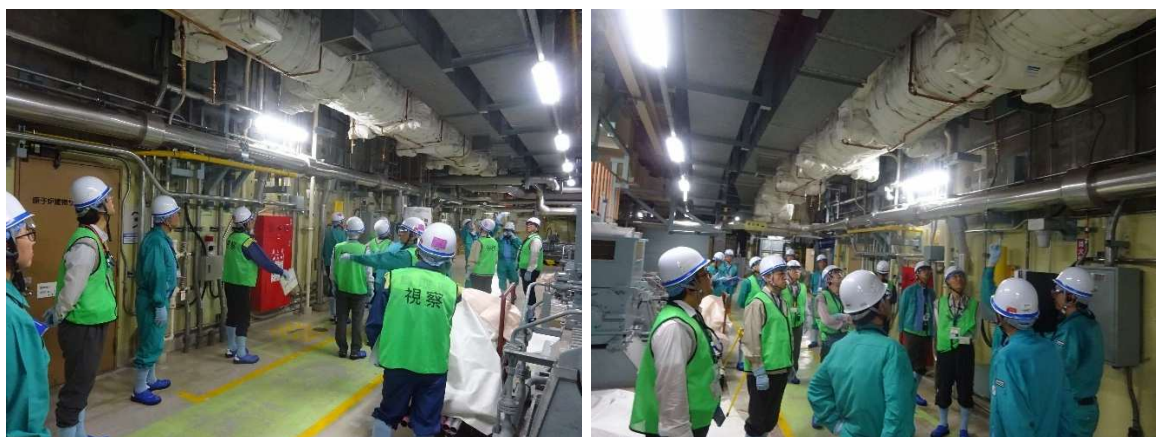
(視察：耐火ラッピング)
