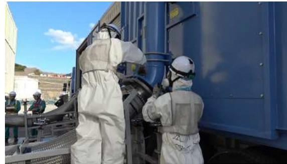
原子炉補機代替冷却系
