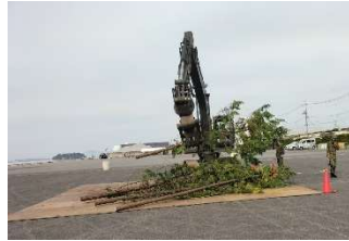
自衛隊等による道路啓開
