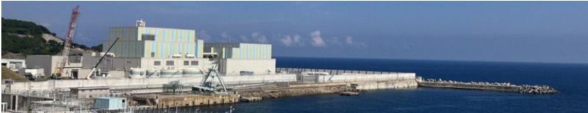
敷地東側からの全景
