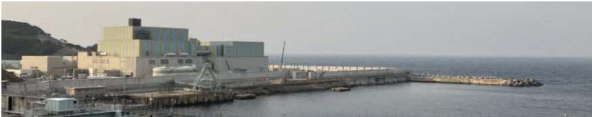
敷地東側からの全景
