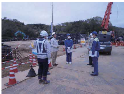
除染廃棄物仮置場での説明
