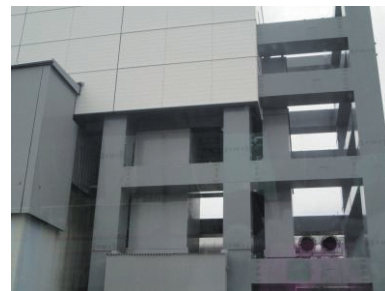
構内バスから見る4号機
