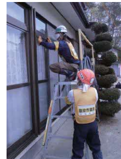
住宅除染作業の状況
