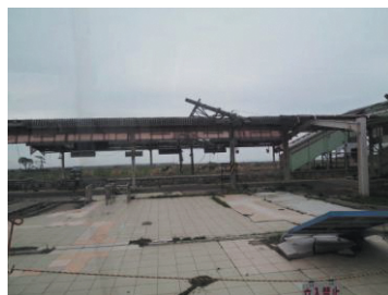
富岡駅周辺津波被害状況
