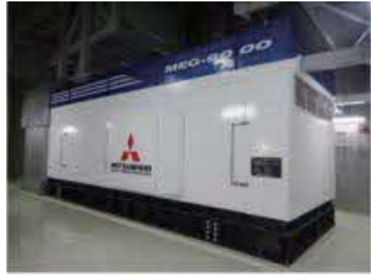
ガスタービン発電機
