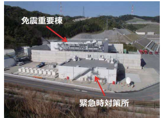
緊急時対策所と免震重要棟
