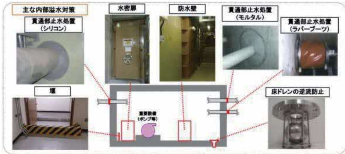
内部溢水対策の例
