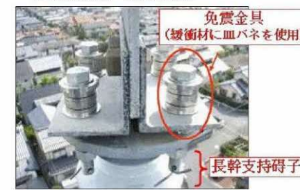
免震対策の施工状況
