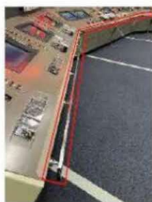
手摺設置状況
