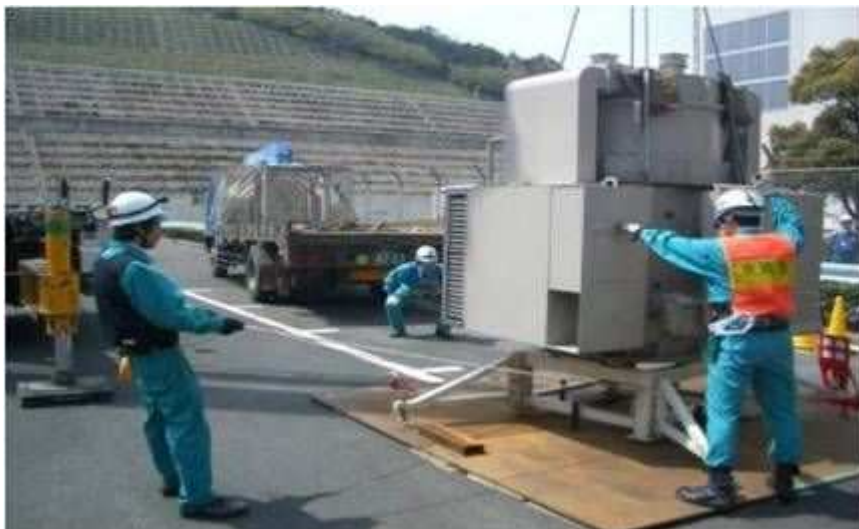
原子炉補機海水ポンプ電動機を予備品へ取り替える訓練の様子
