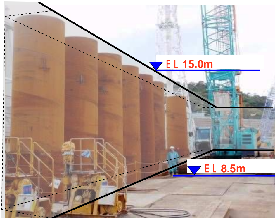
1, 2号機エリア 防波壁工事状況 (平成25年内完成予定)
