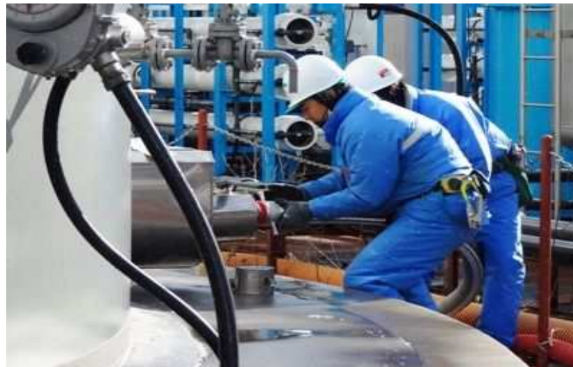
代替注水訓練の様子(水源となるタンクへの接続)
