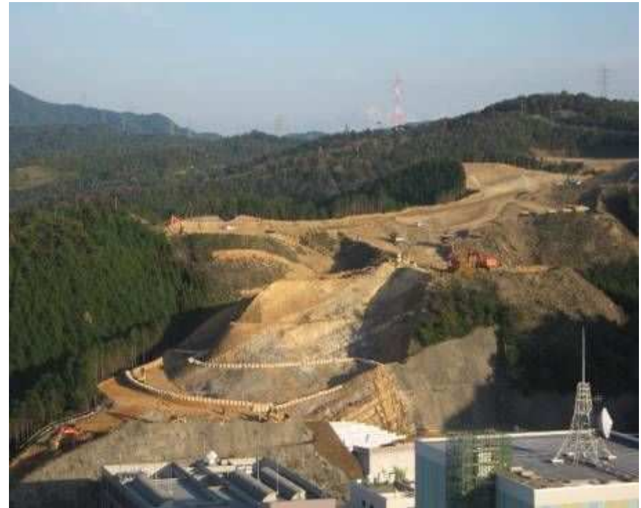
免震重要棟敷地造成工事状況 (平成26年度内運用開始予定)
