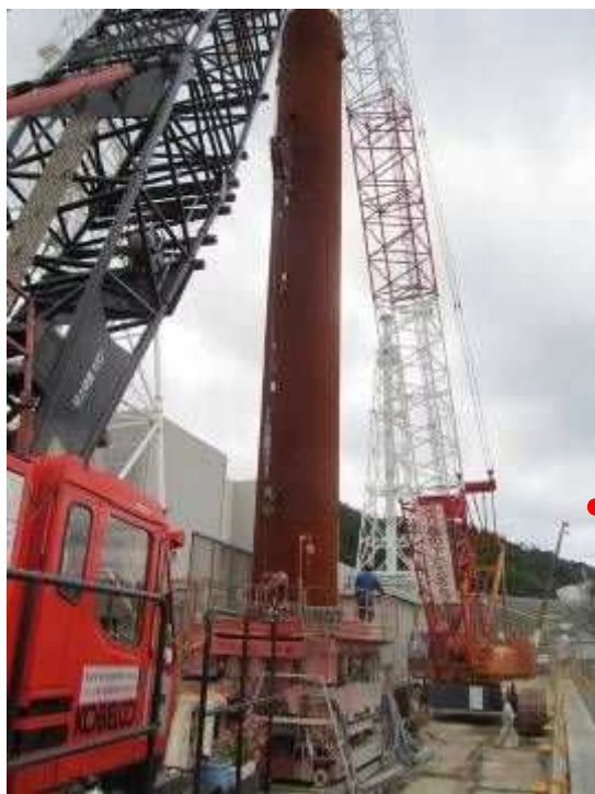
【1,2号機エリアの工事状況】
