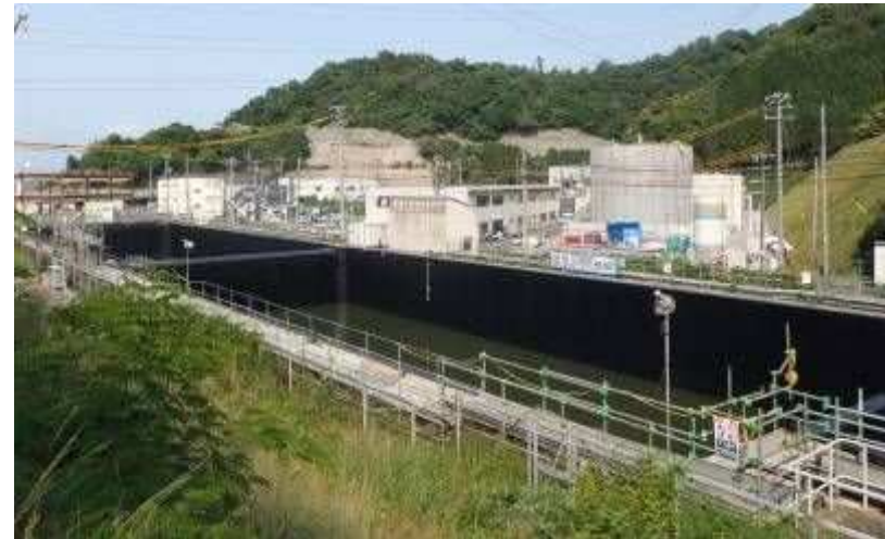
補強工事を終えた輪谷貯水槽
