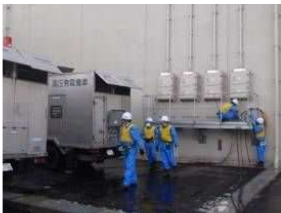
▲ 高圧発電機車を用いた電力供給訓練
