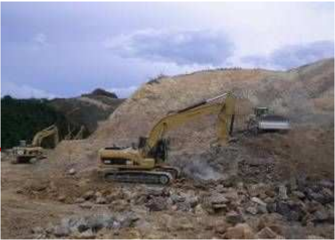
敷地造成工事の状況
